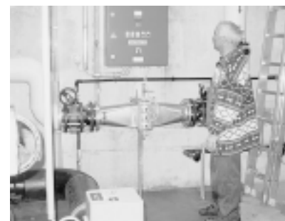
Wasserwarte bei der Arbeit
